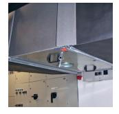
AirStream es un módulo desarrollado por Baro para la instalación en sistemas de aire acondicionado y de ventilación. Este sistema se puede planificar para sistemas futuros de ventilación o ser adaptados los sistemas existentes.
